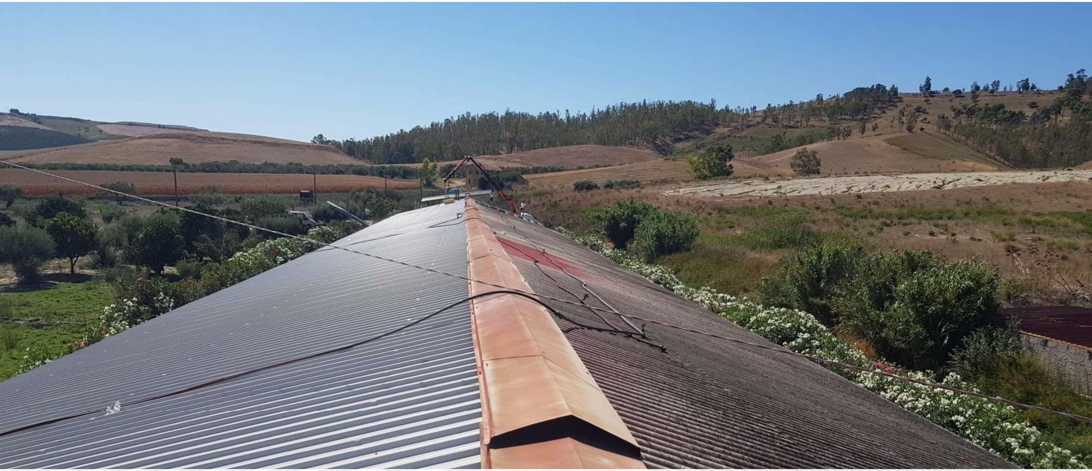
Esempio di intervento su Azienda Agricola – Rimozione amianto + FV Trafinello (CR) – Rimozione 7.000 mq di amianto e realizzazione 1 MW FV
