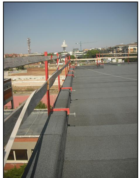
montanti metallici ancorati con morsetti al bordo esistente. Durante la fase di posizionamento della guaina nel perimetro esterno, i lavoratori rimuoveranno per piccole parti il parapetto, vincolandosi preliminarmente con le cinture di sicurezza. La mancanza di punti di ancoraggio e l'impossibilità di forare l'estradosso del
