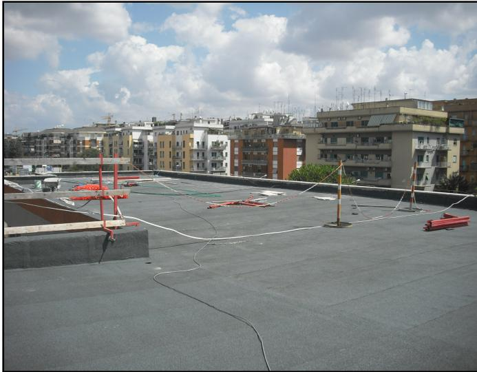
soffitto, ha reso necessario utilizzare come punto di vincolo una trave esistente sul solaio, di cui si è preventivamente provata la resistenza. Nei tratti comunque che non saranno oggetto di lavorazioni e che sono privi di parapetto, verranno collocate delle interdizioni al passaggio dei lavoratori, costituite da catene ancorate a
